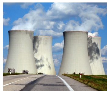
Aussenwände einer Kühlturmanlage, die überschüssige Wärme aus Industrieprozessen abführt (Übung 38).
