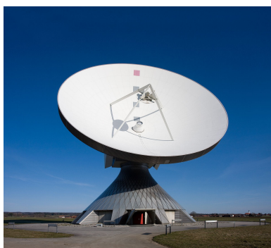
Parabolantenne der Erdfunkstelle Raisting in Bayern (Übung 37).
